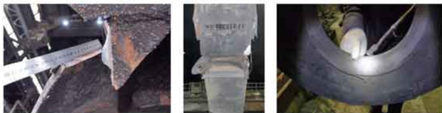
图3 东侧连接立板A、B端现状（组图）
