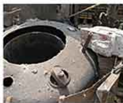
图1 锅炉本体被严重破坏
