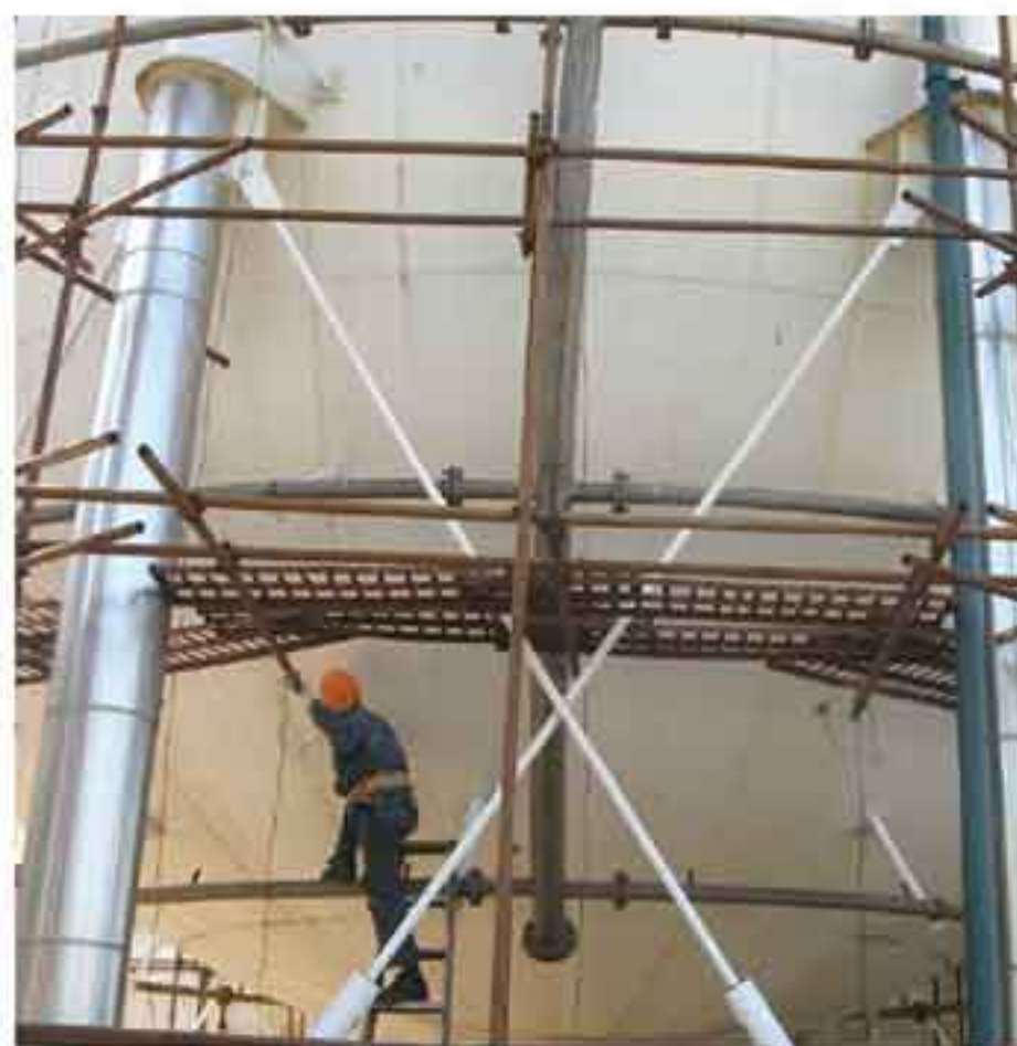
图2 在用球罐支柱实际结构图
