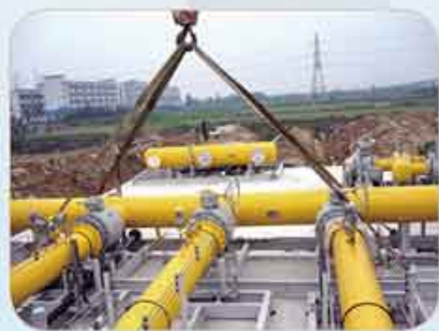
管线设备正在吊装就位中
